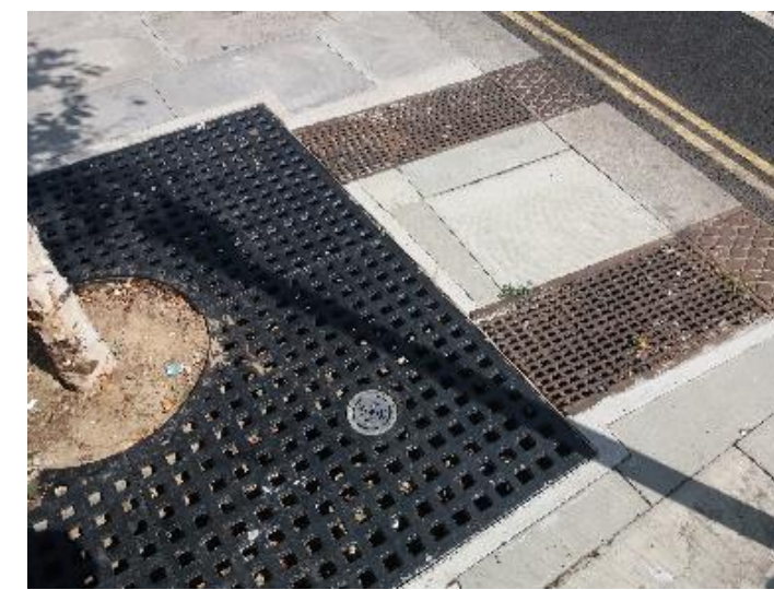
Ci-dessus Parking perméable et réservoir de stockage des eaux pluviales, Royaume-Uni (Londres). Photo : Cerema
